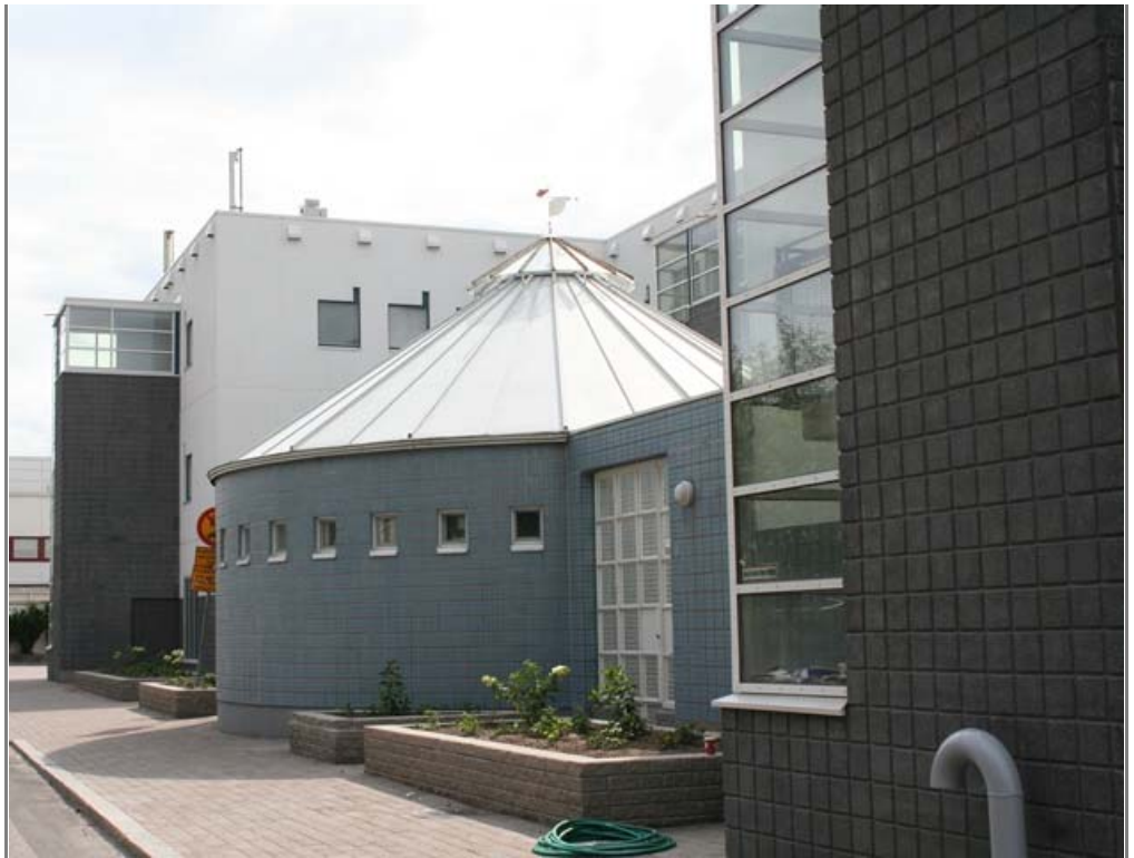
Julkisivut ja sisäpihat on korjattu Kontulan terveysasemalla. Puuikkunoiden oikea-aikainen huoltomaalaus antaa ikkunoille lisää elinikää.
