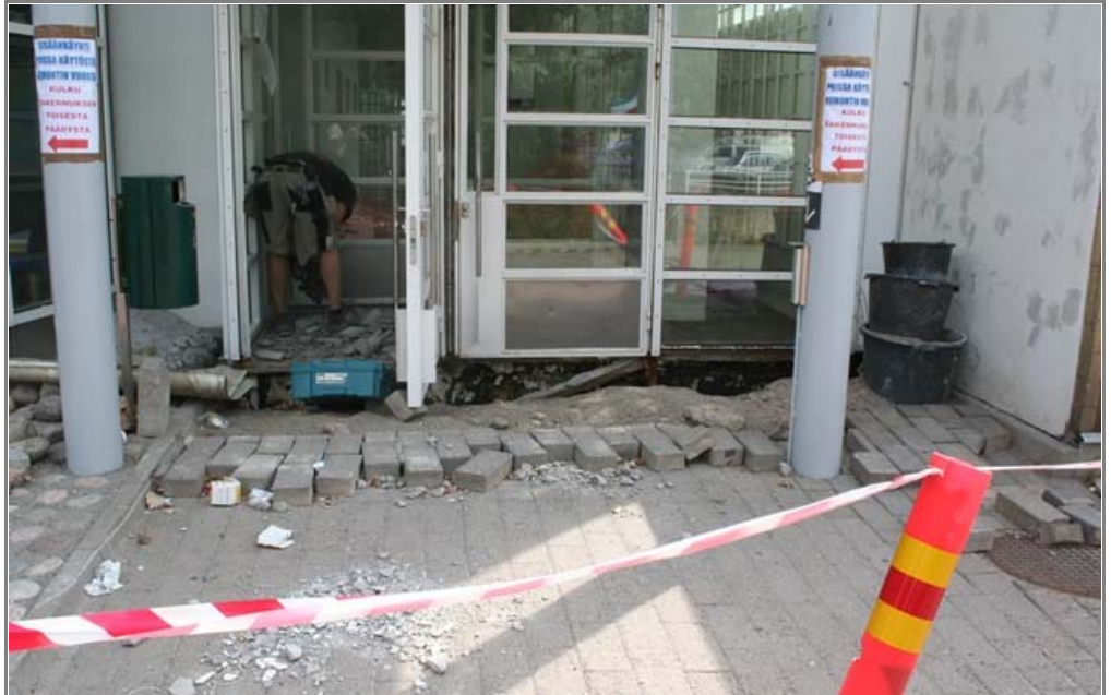
Elokuun 2013 alussa korjausmiehet olivat töissä vielä rakennuksen toisessa sisäänkäynnissä ja porrastornissa.
