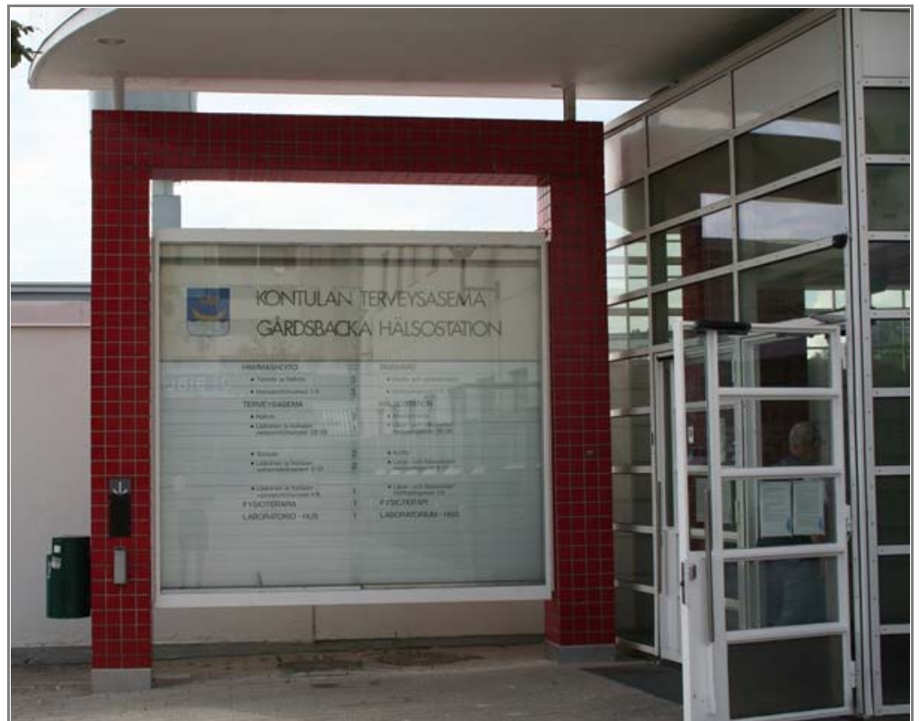
Kontulan terveysasemalla tehtiin rakenteellinen kuntotutkimus 2010. Rakennusta on korjattu kuntotutkimuksesta saatuun tietoon pohjautuen vuosina 2012 ja 2013.
