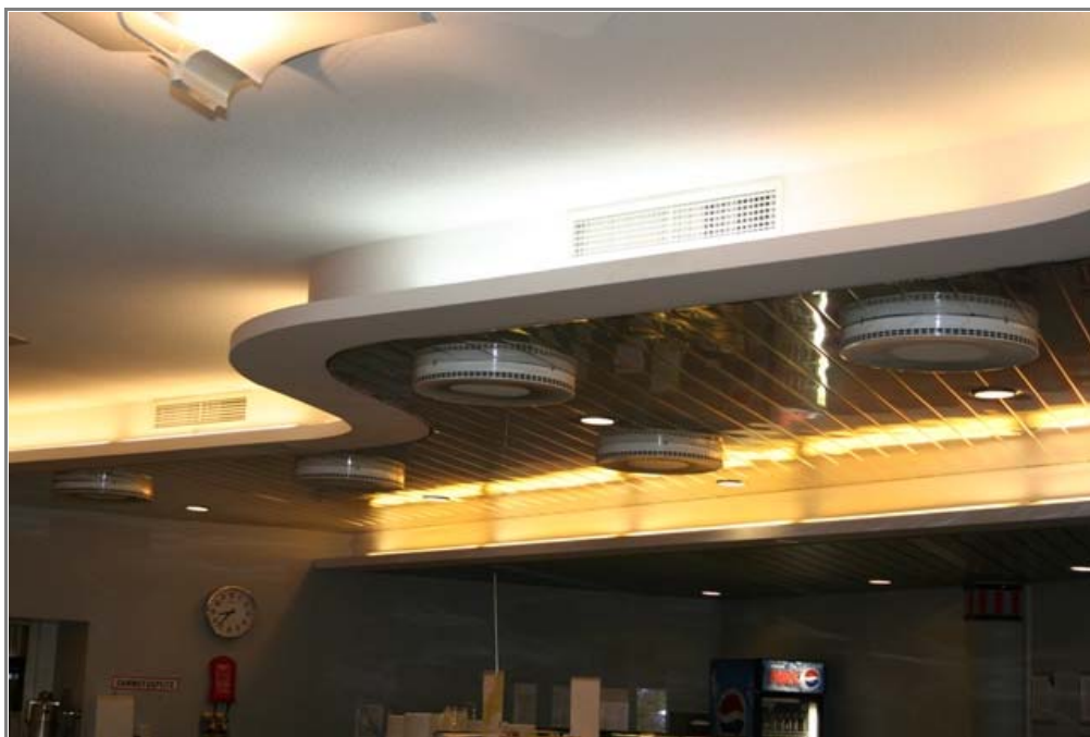
Ilmanvaihdon tarkoitus on tuoda tiloihin raitista ilmaa. Erikoishuollon tehtäväkuvien selkeyttämisellä halutaan varmistaa, että laitteet ja järjestelmät toimivat suunnitellusti.
