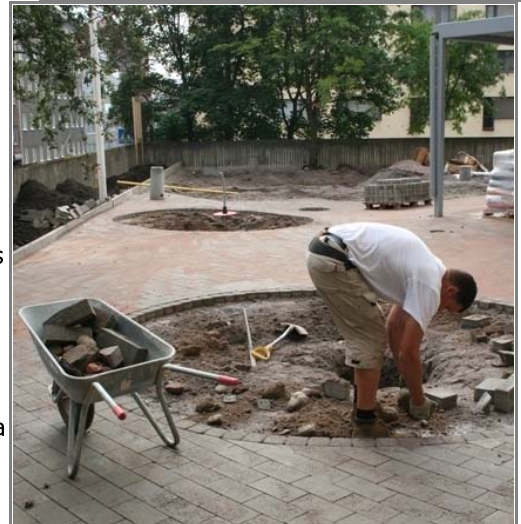
Päiväkodin piha remontoitaa nykyvaatimuksia vastaavaksi. Lasten turvallisuus on yksi tärkeä suunnittelua ja rakentamista ohjaava tekijä.
