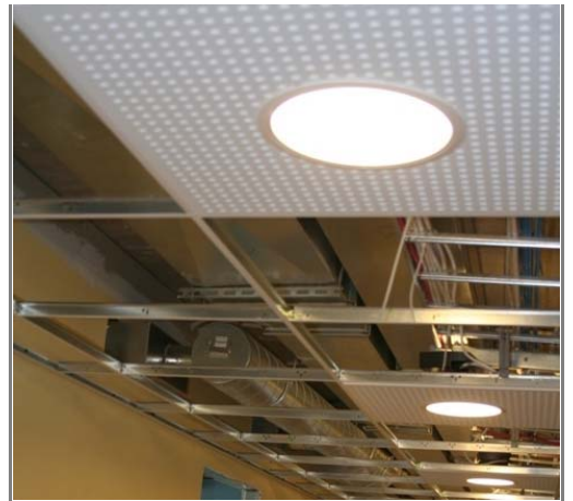
Työn yhteydessä päiväkotikäyttöön tulevassa tilassa uusitaan mm. ilmanvaihto ja valaistus.
