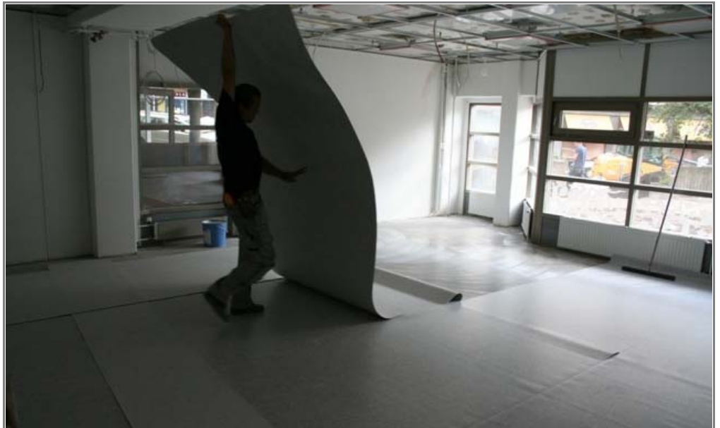
Kuvassa on käynnissä lattiamattojen asennus.
