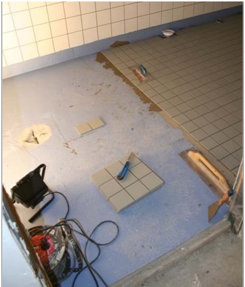
Päiväkoti tarvitsee nykyaikaiset märkätilat. Vesieristyksen asennuksen jälkeen on vuorossa laatoitus. Kohteeseen tulee myös inva-mitoitettu wc-tila.
