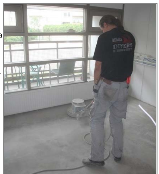
Pinnat uusitaan päiväkotia varten. Tässä hiotaan lattiaa ennen päällysteen asentamista.
