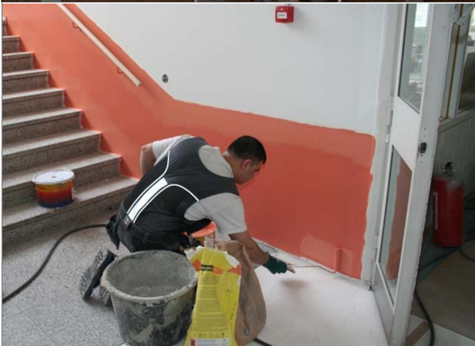
Rakentajat tekivät työtään ahkerasti myös harjannostajaispäivänä.
