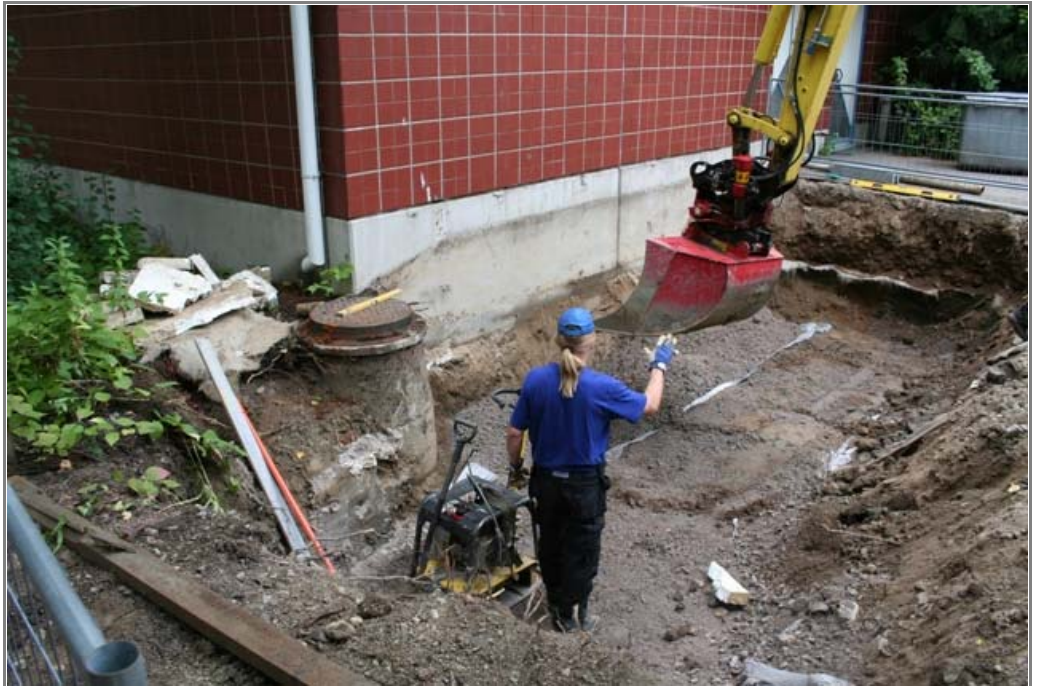
Malminkartanon terveysasemalle asennettiin uudet jätesäiliöt. Tässä urakoitsija tekee kuoppaa uusille Molok-astioille.
