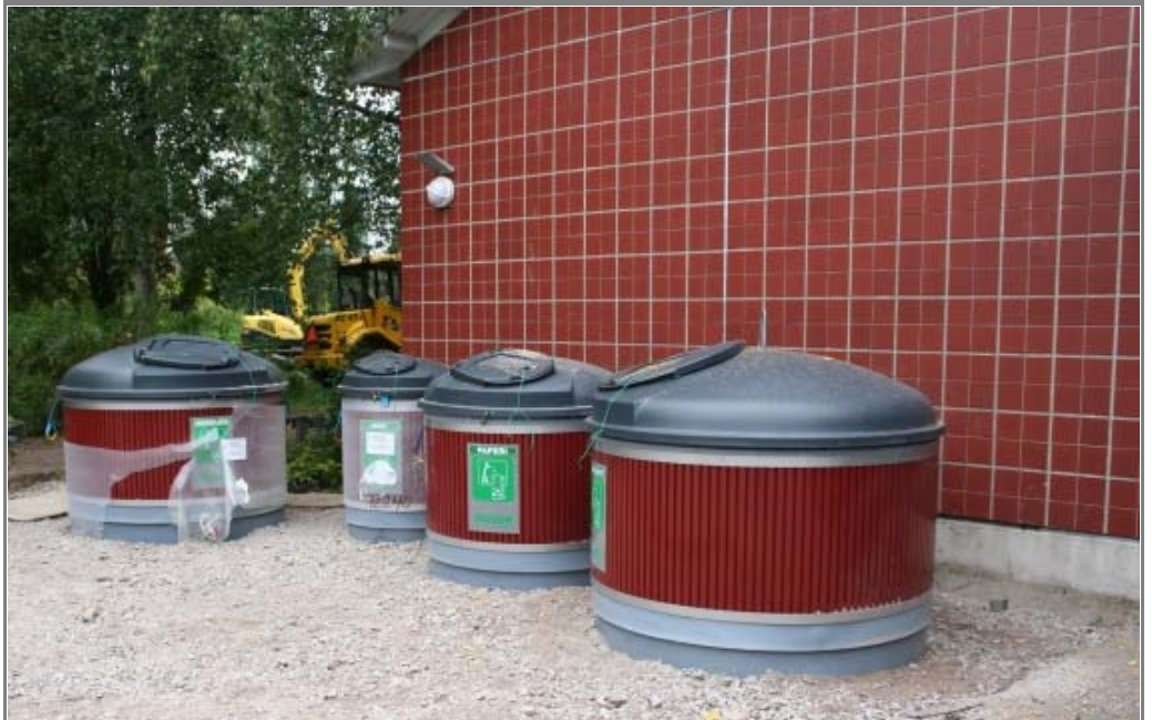
Uudet jätesäiliöt saatiin siististi paikalleen päivässä. Molokien ansiosta jäteauton vierailut Malminkartanon terveysasemalla harvenevat merkittävästi.
