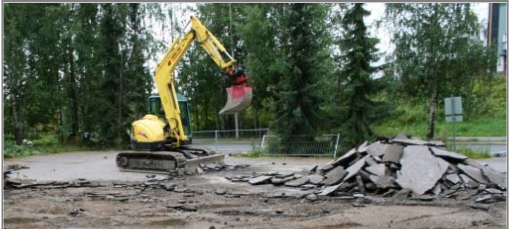
Malminkartanon terveysasemalla tehdään jätejärjestelmän ohella muitakin piha-alueen kunnostustöitä. Tässä pistetään uusiksi terveysaseman pysäköintialuetta.
