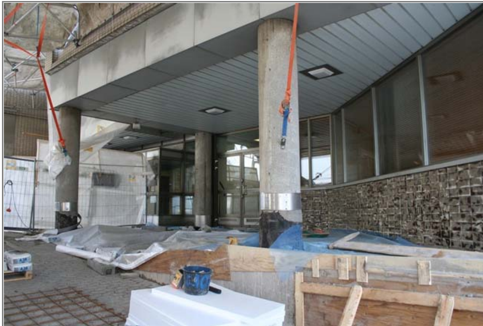
Sisäänkäyntityömaa metroasemalta päin katsottuna. Oikealla edessä näkyy valos, jolla täytettiin vanha porras ja nostettiin reunusta pyörien säilytystilaa varten. Tästä puuttuu vielä metallikaide sekä uusi seinälaatoitus. Uusi ramppi, johon valoaihe tuo ilmettä sekä tässä että pääsisäänkäynnin kohdalla, on pilarien välissä ja nousee sekä kohti ovea että pyörien säilytystilaa.
