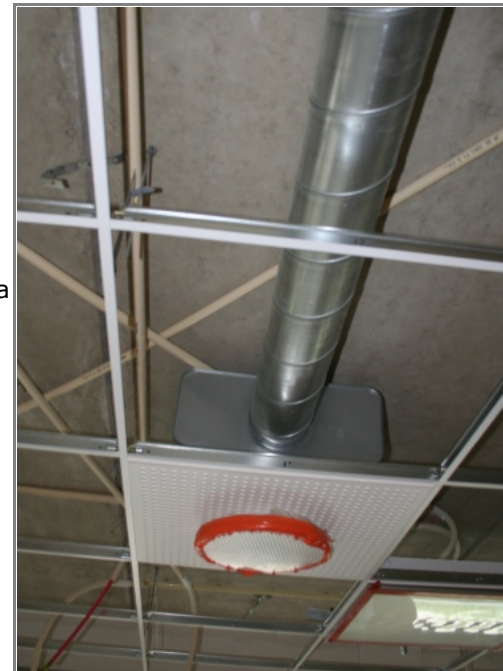
Kun aiemmin nuorisokeskuksen käytössä ollut tila Porthaninkatu 2:ssa muutettiin päiväkotiksi Kalevaksi, tehtiin tiloissa myös ilmanvaihtoon liittyviä muutostöitä.
