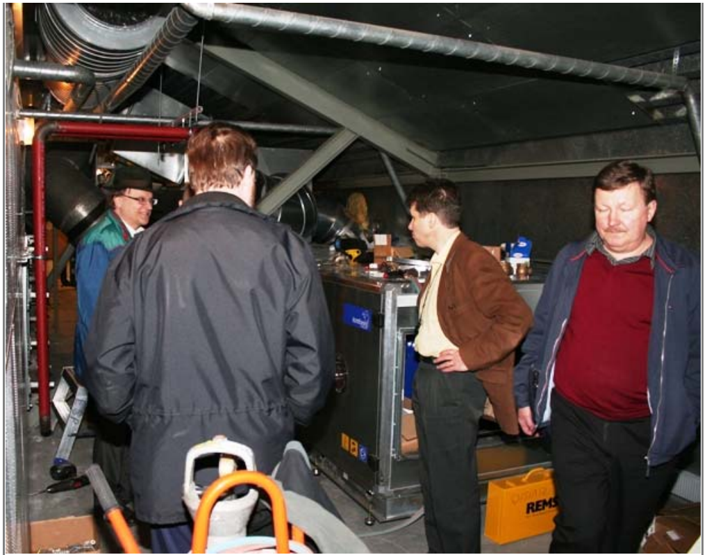
Ennen työmaakokousta hankkeen eri osapuolet tutustuivat työmaan setheteeseen tilanteeseen.
