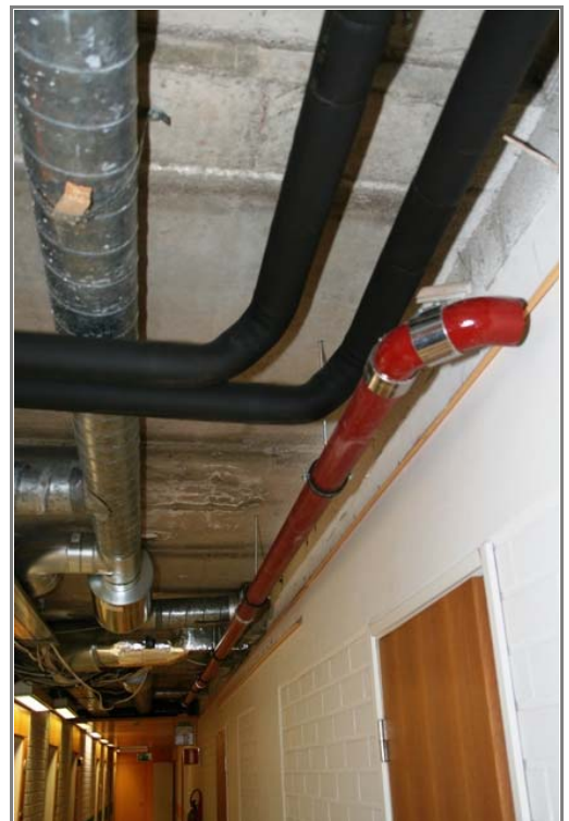
Ilmanvaihdon parantamisessa joudutaan tekemään Sturenkatu 14:ssä aika vähän töitä toimistotiloissa. Rakennuksen 8. kerroksessa on tehty uusia putkivetoja osana uusien koneiden asennusta. Työtiloissa on tehty rakennustöitä virka-ajan ulkopuolella.
