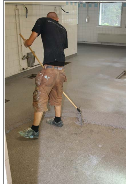
Helsingin sosiaali- ja terveysalan oppilaitoksen keittiötilojen lattia- ja seinäpinnat uusittiin vuonna 2010 tehdyssä remontissa.
