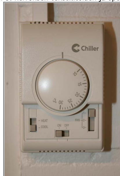
Sturenkatu 8:ssa tehtiin korjaustöitä, joilla ennen työterveysaseman käytössä olevat tilat muutettiin sosiaaliviraston tarpeisiin sopiviksi. Yksi osa hanketta oli kiinteistön liittäminen kaukokylmään ja jäähdytyksen tuominen kiinteistön työtiloihin.
