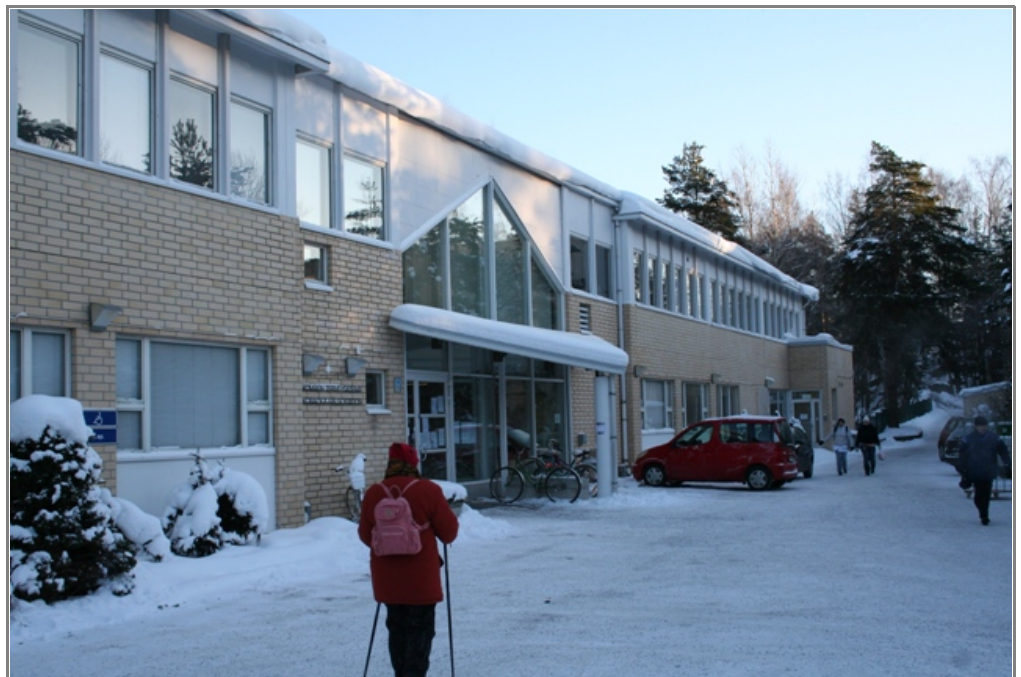
Jakomäen terveysasemaa on huollettu kesällä 2010 julkisivua ja peltikattoa maalaamalla. Säännöllinen huolto pitää rakennuksen kunnossa.
