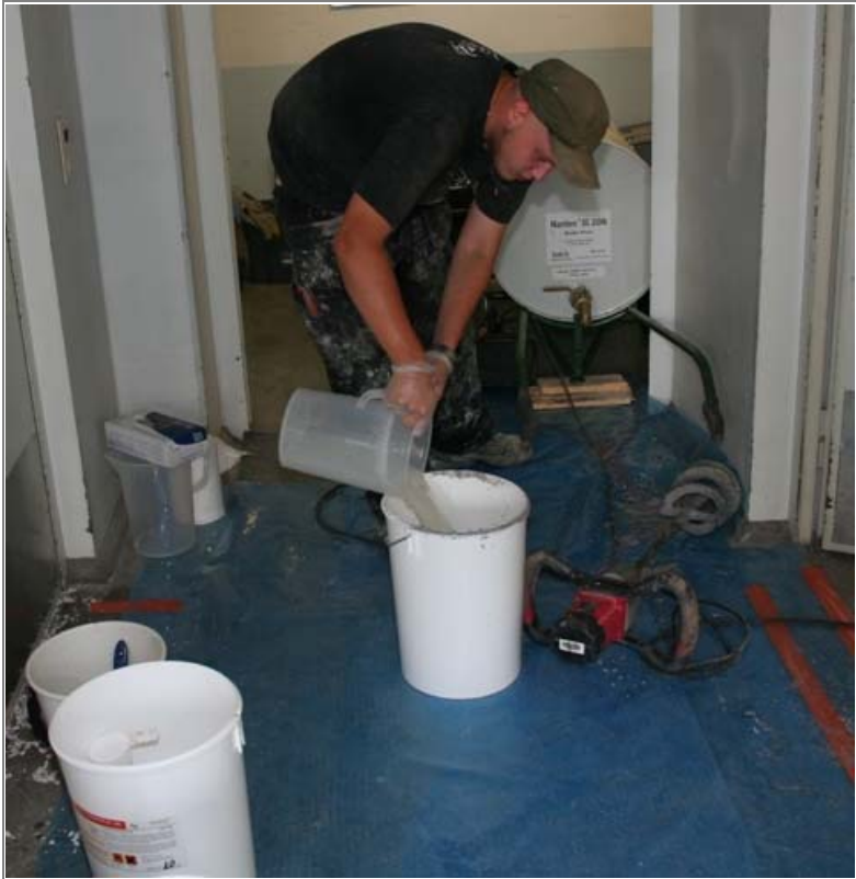
Varsinainen pinnoite sisältää mm. akryyliä. Näin lattian kestävyys kosteissakin oloissa on hyvä. Pinnoitteen kuivumisen jälkeen lattia vielä lakataan viimeistenkin huokosten tukkimiseksi.
