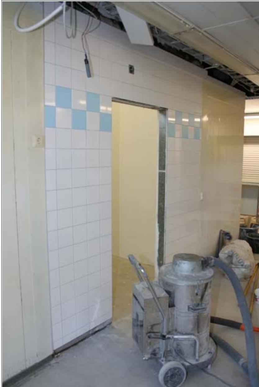
Tarkkaavainen katsoja saattaa huomata, että vanhan vuonna 1989 asennetun ja uuden vuonna 2010 asennetun seinäpinnoitteen värisävyissä on aavistuksen eroa uuden sinisen laatan ja saumalaastin osalta.
