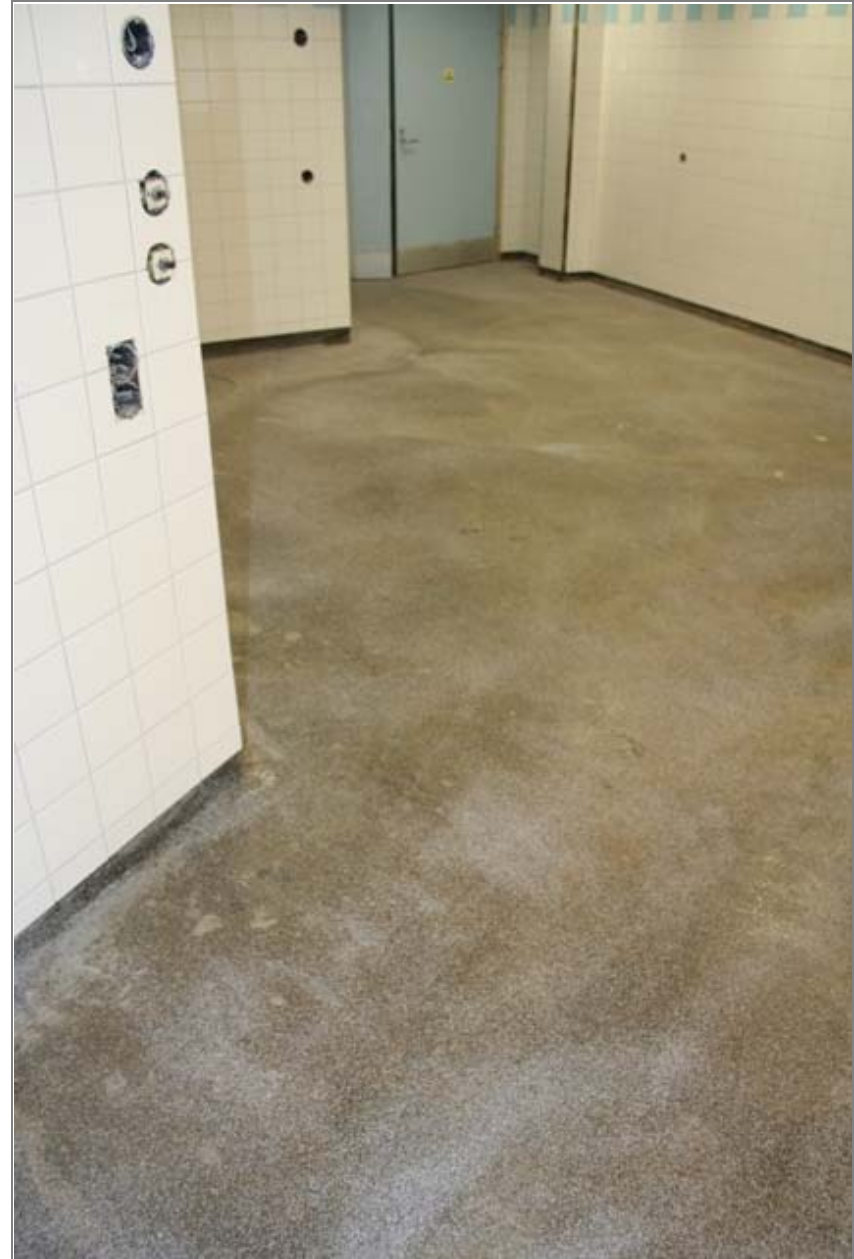
Lattiat käsiteltiin epoksipohjaisella vedeneristeaineella ennen lopullisen pinnoitteen asentamista.
